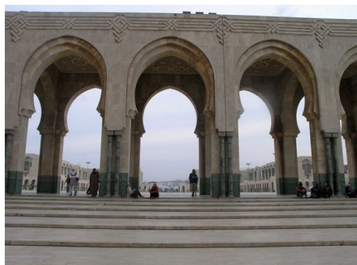
Ryc. 71. Maroko. Casablanka. Meczet Hassana Drugiego. Główny osiowy portybek. Oddziela główny plac przed wejściem do świątyni, od następnego placu pomocniczego, który przylega do obwodnicy nadmorskiej miasta. Po dwóch stronach placu pomocniczego widoczne pierzeje budynków związanych programowo z meczetem. Źródło: Fot. autora
