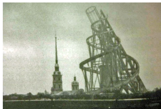
Ryc. 3. Projekt gmachu Trzeciej Międzynarodówki Komunistycznej inspirowany Wieżą Babel. Autor – konstruktywista/suprematysta radziecki Władimir Tatlin. Fotomontaż ukazujący 400-metrową budowlę (wysokość równa WTC w Nowym Jorku) na tle Gmachu Admiralicji w Petersburgu/ Piotrogradzie/ Leningradzie/ Sankt Petersburgu. Plansza w Museum of Modern Art MOMA w Nowym Jorku. Źródło: www.moma.org
