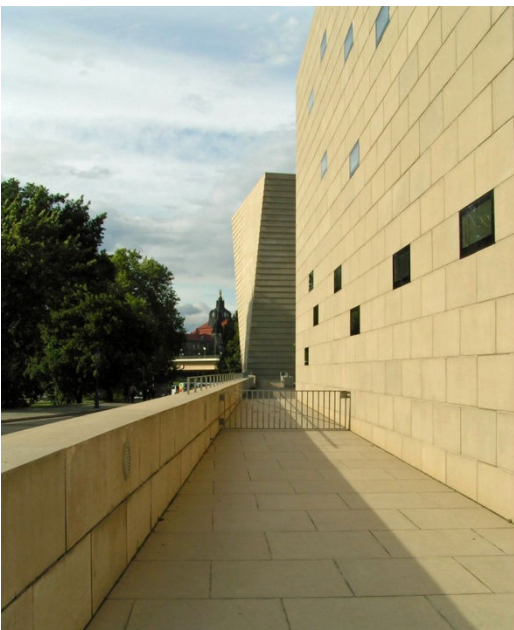
Ryc. 75. Niemcy. Drezno. Nowa Synagoga. Jedna z galerii zewnętrznych doprowadzająca do placu wspólnego znajdującego się między dwoma budynkami synagogi. Źródło: Fot. Przemysław Kowalski.
