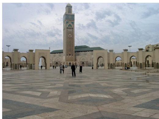
Ryc. 69. Maroko. Casablanka. Meczet Hassana Drugiego. Widok wzdłuż głównej osi, od strony miasta, od południa, w kierunku głównego wejścia. Uwagę zwraca ciekawy układ placów publicznych w formie trójlistka koniczyny, oddzielonych portykami arkadowymi. Źródło: Fot. autora
