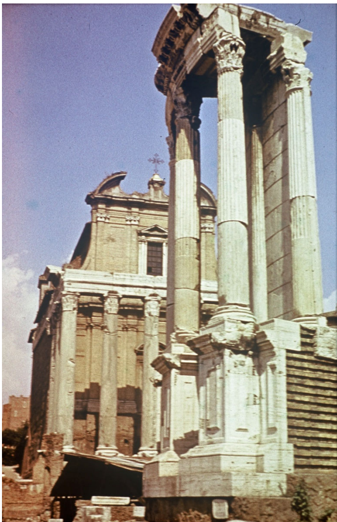
Ryc. 12. Włochy. Rzym. Forum Romanum. Antyczna świątynia Antoninusa i Faustyny, przebudowana podczas kontrreformacji na kościół chrześcijański, przy pozostawieniu antycznego portyku. W drugim planie – w głębi wymieniono fasadę antycznej bazyliki na fasadę barokową. Źródło: Fot. autora
