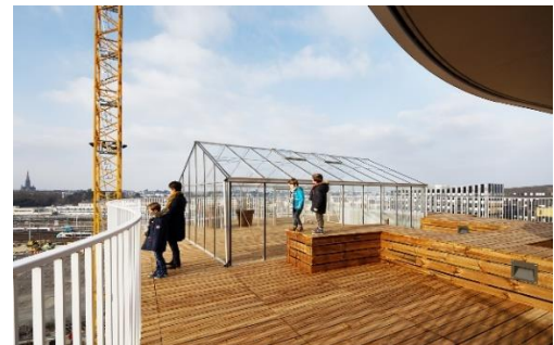
Fig. 13 Common external terrace with a greenhouse in New'R Tower, ZAC Euro Nantes (Nantes, France). Authors: Hamonic + Masson & Associates (2017) © Takuji Shimmura Ryc. 13 Wspólny taras ze szklarnią w budynku wysokim New'R Tower, ZAC EuroNantes (Nantes, Francja). Autorzy: Hamonic + Masson & Associates (2017) © Takuji Shimmura
