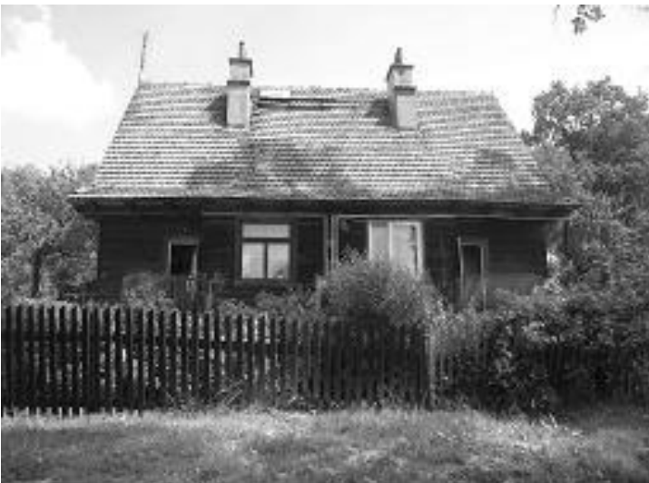
Ryc. 10. Domek na osiedlu w Zagnańsku. Źródło: fot. M. Furtak
