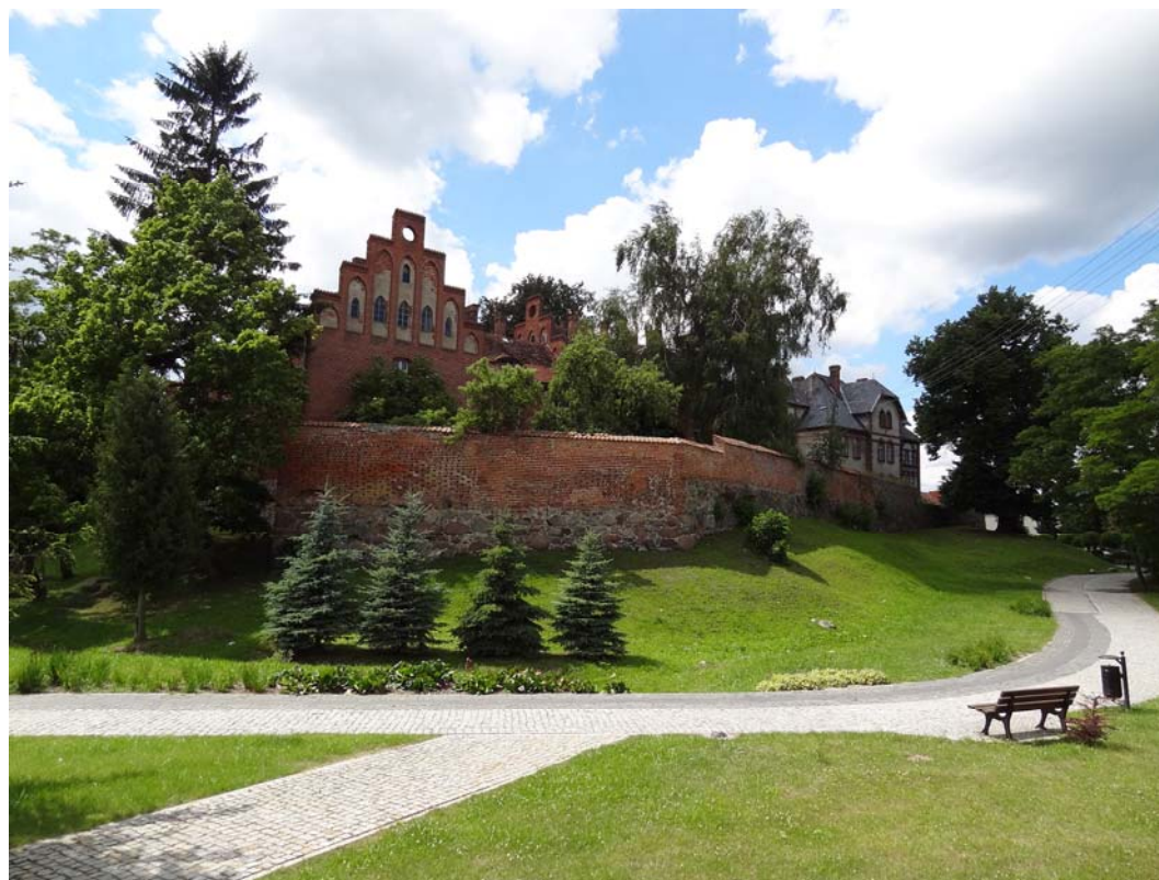
Ryc. 1. Stan istniejący zamku w Sztumie. Źródło: fot autor
