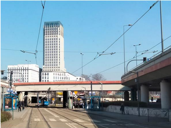
Sector A: Mogiłskie roundabout
