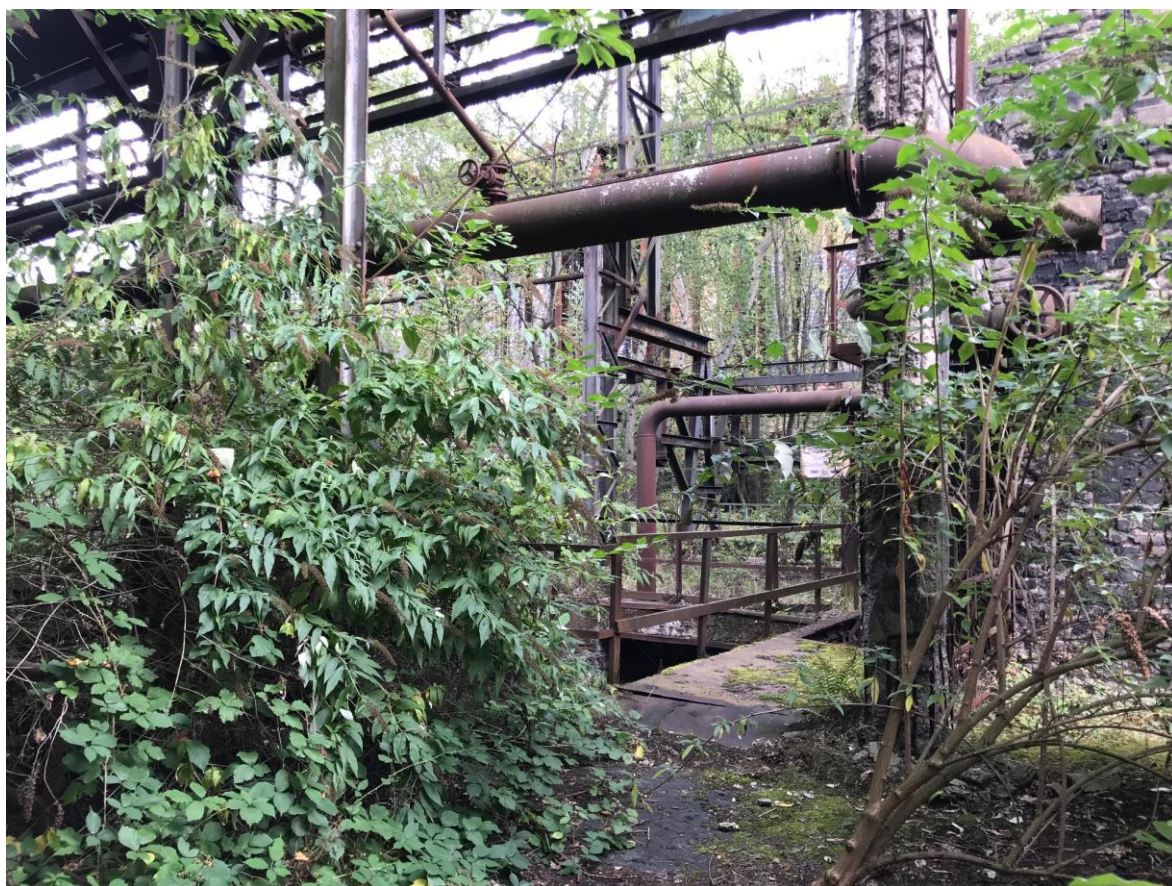
Fig. 1. Völklingen „Paradise” -odzyskany raj na terenie dawnej koksowni, fot. U. Forczek-Brataniec
