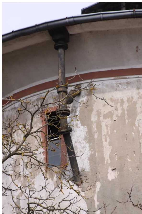
Fig. 7. Zasilanie zbiornika wodnego wodą deszczową – detal, kolejowa wieża ciśnieniowa w Sierakowie Wielkopolskim, typ R05, ©RB 2021.
