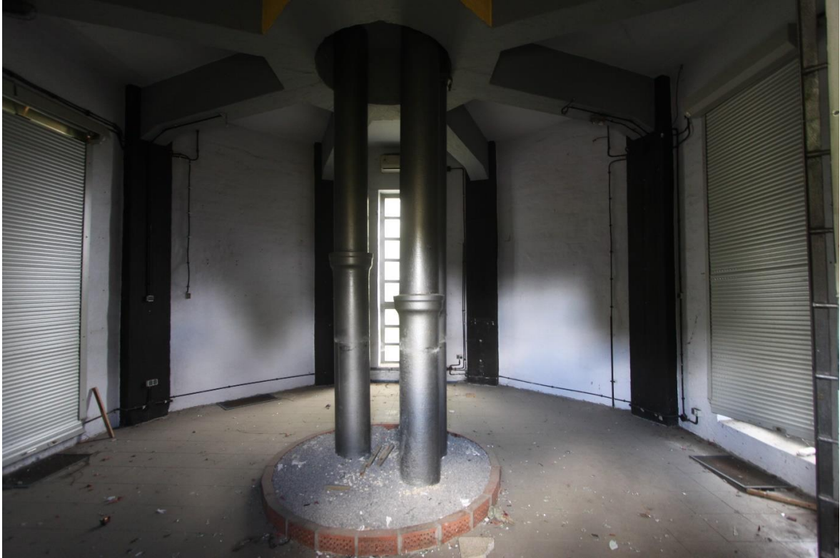
Fig. 3. Interior of the ground floor of type R27 railway water tower (installation incomplete), in Poznań, ©RB 2021. Ryc. 3. Wnętrze przyziemia kolejowej wieży ciśnieniowej typu R27 (zdekompletowana instalacja), Poznań, ©RB 2021.
