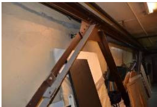
Ryc. 43. Widoczna w piwnicach budynku konstrukcja szkieletowa kratownicowa, stalowa, nitowana. Źródło: fot. autorka. Fig. 43. In the basement of building visible trussed, steel, riveted building frame. Source: photo by author.
