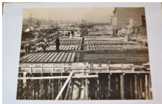
Ryc. 17. Zdjęcie prac inżynierskich przebudowy cieków wodnych w obrębie Placu Kamilińskiego. Źródło: Dariusz. Walerjański.
