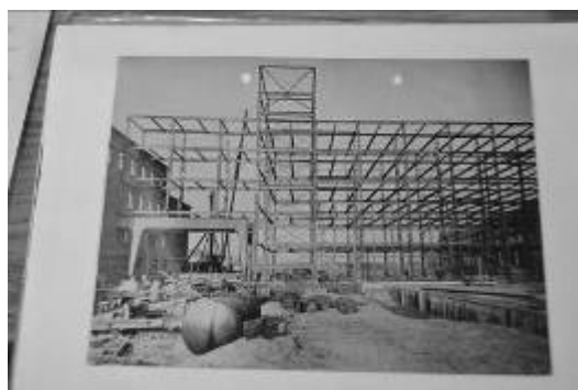
Ryc. 34. Konstrukcja stalowa Szkoły Zawodowej (dziś Klinika Stomatologii) Po lewej nitowane ramy przejazdu ulicznego. Źródło: Dariusz. Walerjański.
