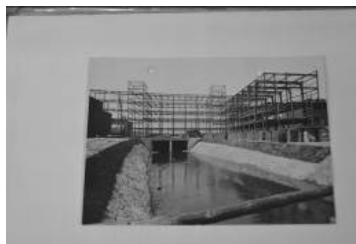
Ryc. 35. Konstrukcja stalowa Szkoły Zawodowej (dziś Klinika Stomatologii). Widok na wpływającą pod konstrukcję rzekę Bytomkę. Źródło: Dariusz. Walerjański.
