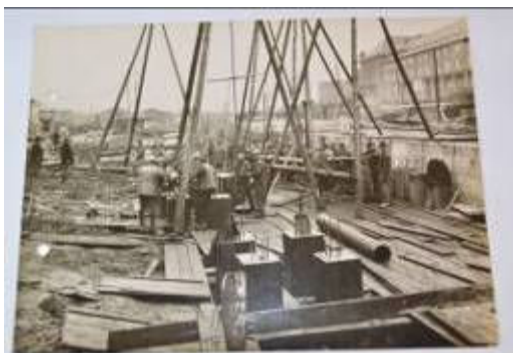
Ryc. 15. Zdjęcie prac inżynierskich przebudowy ciek wodnego w obrębie Placu Kamiliańskiego. Źródło: Dariusz Walerjański.
