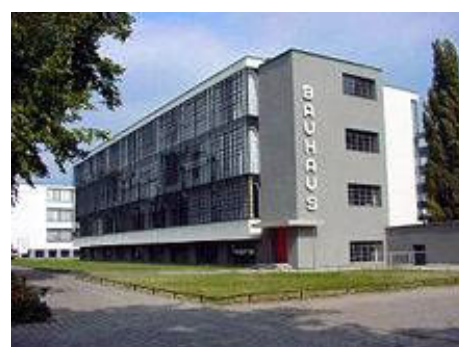
Ryc. 8. Walter Gropius - Budynek Bauhausu w Dessau, 1925 Źródło:
