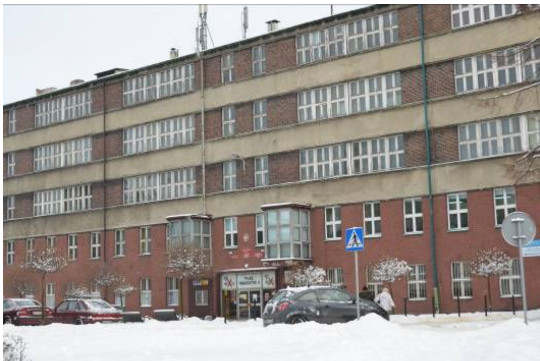
Ryc. 33. Elewacja frontowa Kliniki Stomatologii (Szkoła Zawodowa). Widok z Placu Traugutta (Placu Kamiliańskiego). Pomiedzy wykuszami wejście główne. Źródło: fot. autorka.
