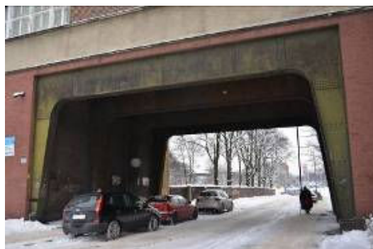
Ryc. 36. Stalowe nitowane ramy przejazdu ulicznego pod budynkiem Kliniki Stomatologii. Źródło: fot. autorka.
