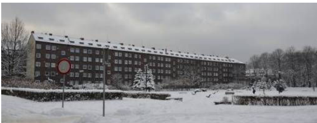
Ryc. 38. Elewacja północna budynku mieszkalnego przy ul. Góry Św. Anny. Widok z Placu Traugutta.
