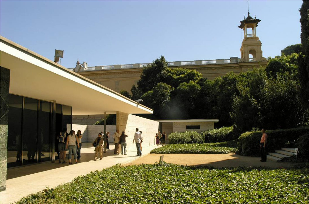
II.21 Widoki w kierunku południowo wschodnim. Skala, gabaryty, forma, materiały, wykonawstwo, szata zielona, jakość utrzymania – powodują że obiekt skrajnie nowoczesny jest idealnie wpisany w znakomity kontekst zabytkowy centrum stolicy Katalonii.
