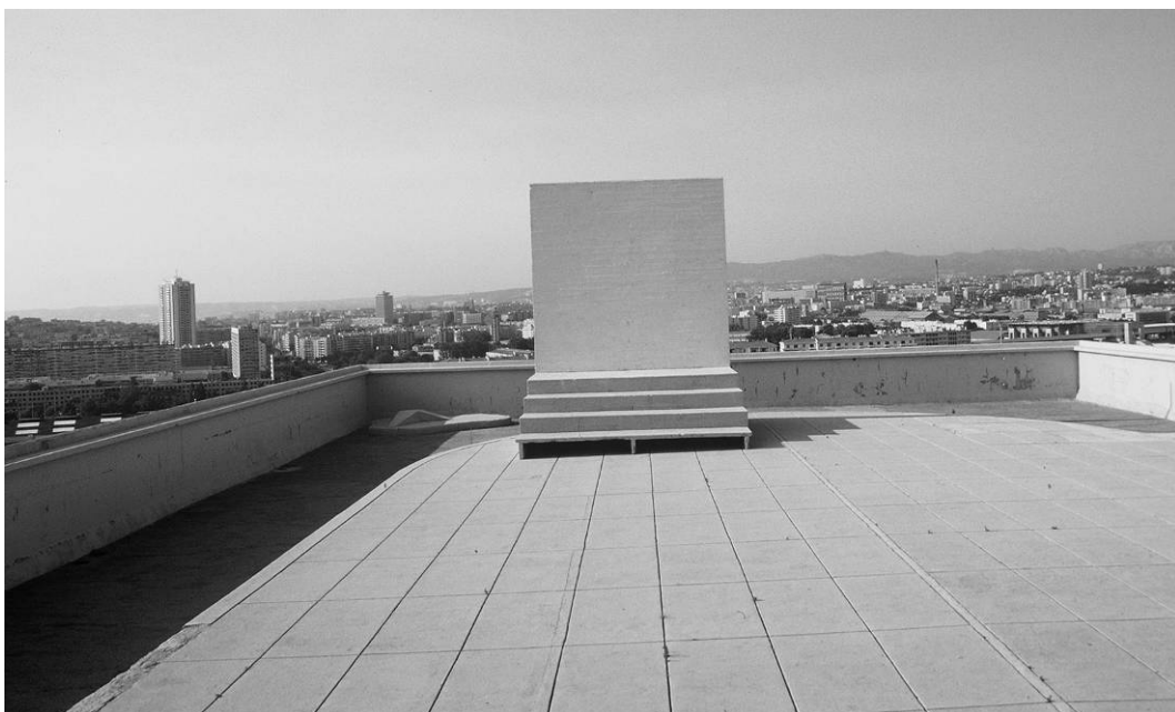
Il.7. Taras na dachu, kino – estrada. Betonowy ekran spełnia również rolę akcentu plastycznego i osłony przeciw wiatrowej.
