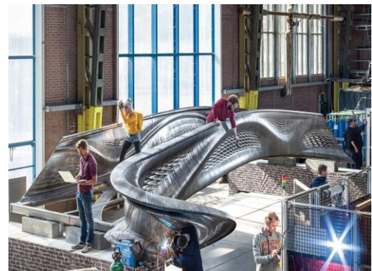
Fig. 4. MX4D bridge - first indoors tests Ryc. 4. Most MX3D – testy obciążeniowe (MX3D, 2020)
