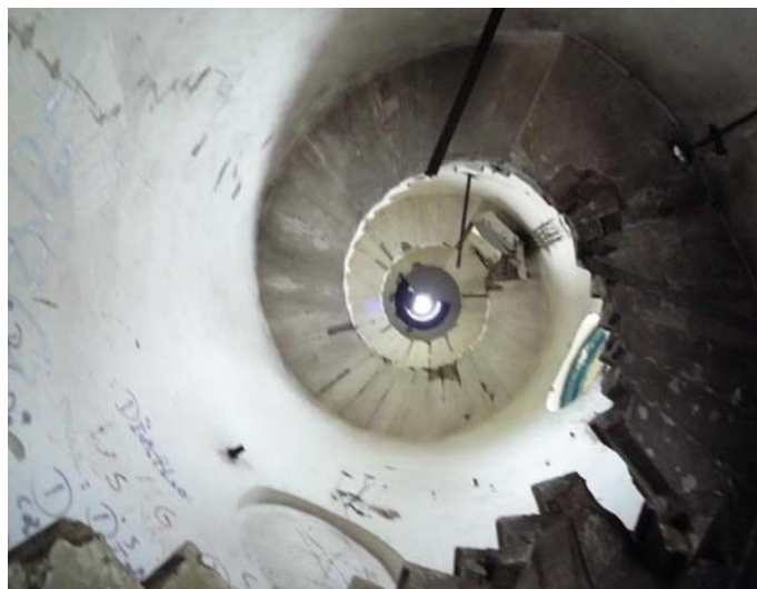
Ryc. 12. Spiralna klatka wewnątrz trzonu wieży w Brodnicy. Źródło: il. autora.
