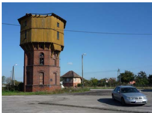
Ryc. 5. Wieża ciśnień w Szubinie. Źródło: il. autora Fig. 5. Water tower in Szubin. Source: Author's photo
