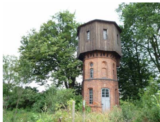
Ryc. 6. Wieża ciśnień - Wrocki. Źródło: il. autora. Fig. 6. Water tower in Wrocki. Source: Author's photo
