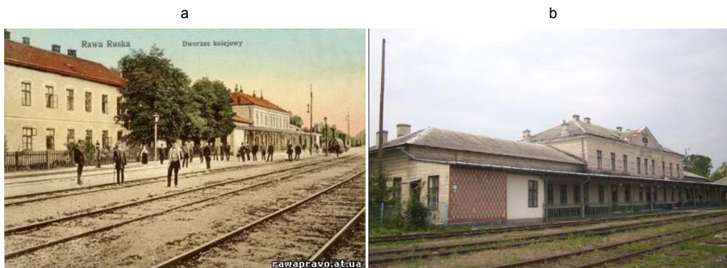
Rys. 6. Rawa Ruska. a) dworzec kolejowy, 1887; b) dworzec kolejowy - widok współczesny. Źródło: a), b) [19]. Fig. 6. Rava-Ruska: a) Railway Station, 1887; b) Railway Station – the current state. Source: a) – b) [19].
