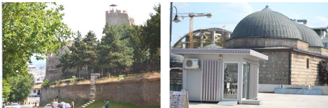
Ryc. 29 Filharmonia (na planie 16A numer 19) widoczna z dystansu w kontekstach urbanistycznych. Ambitna łupinowa budowla została przerwana w procesie inwestycyjnym z powodu wydatków na ekлекtyczny łuk triumfalny wg Programu Skopje 2014 (fot. 48, 49) . --- A. Daleka perspektywa Filharmonii od zachodu spod cytadeli. - -- B. Odległy kadr z głównej osi, od północnego zachodu, z pobliza łaźni południowej po prawej, tożsamej z widoczną na fot. 27A
