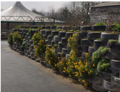
Ryc. 4. Ściana akustyczna wykonana z opon - z nasadzeniami rodzimego pochodzenia formującymi „zieloną” ścianę. Szkoła podstawowa w Dartinton Źródło: Fot. Autora, 2012.
