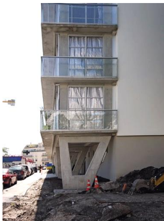
Fig. 21. View of the side wall with added verandas and terrace. Source: phot: a+t reseach group. August, 2015 Ryc. 21. Widok bocznej ściany z dobudowanymi werandami i tarasem. Źródło fot: a+t Magazine reseach group. sierpień, 2015
