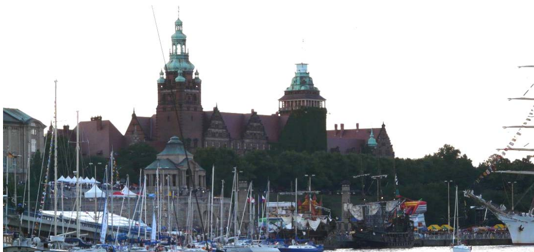
Il. 8. Budynek Urzędu Wojewódzkiego w Szczecinie. Źródło: fot. autora Pic. 8. The building of Westpomeranian Voivodship Office in Szczecin. Source: author's photo
