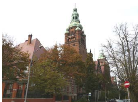
Il. 9. Budynek Zachodniopomorskiego Urzędu Wojewódzkiego. Źródło: fot. autora
