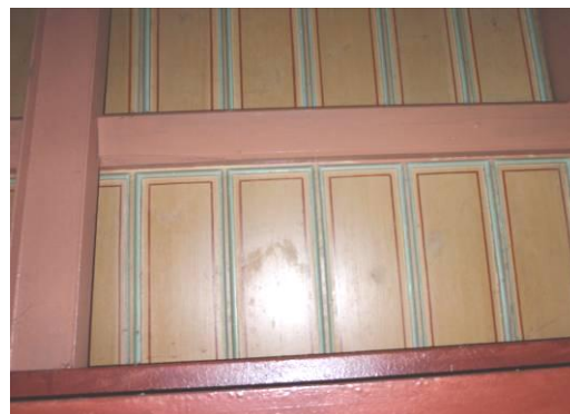
Ryc. 2. Zdjęcie malatury, oznakowanie i zabezpieczenie jej; przegląd konstrukcji empory chórowej; naprawa, uzupełnienia w zakresie konstrukcji; pokrycie jej zabezpieczeniami p.poż. i przeciw erozji biologicznej; konserwacja malatury na podbitce chóru. Źródło: fot. H. Rutyna XI.2010
