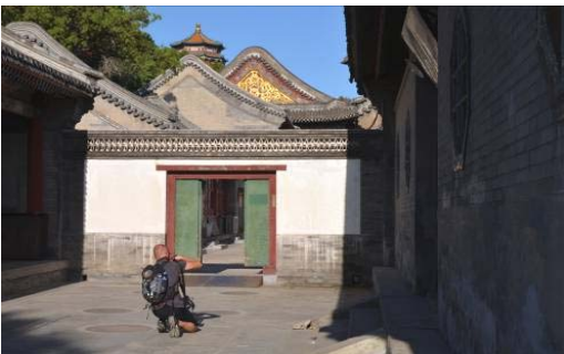
Ryc. 11 Charakterystyczne „minimalistyczne” przejście amfiladowe w zabytkowym zespole śródmiejskim. Źródło: Fot. autor
