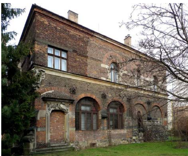
Il. 4. Elewacja ogrodowa po przebudowie werandy. Źródło: fot. autora
