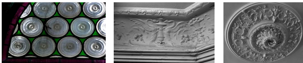
Il. 8. Elementy dekoracji willi Pod Kozłem w Bochni – witrażowe gomółki w oknach, gipsowe stiuki w salonie (gzyms podsufitowy i plafon). Źródło: fot. autora
