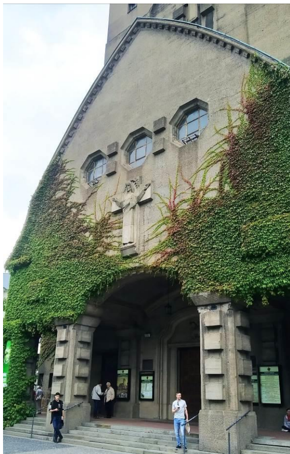
Fig. 1. Climbers growing on the church facades. Source: Jarosław Piesik Ryc. 1. Pnącza porastające fasadę kościoła. Źródło: Jarosław Piesik
