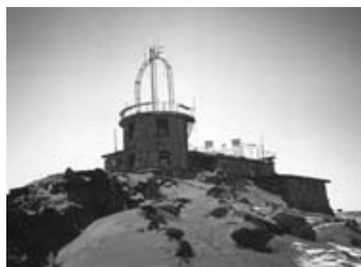
Il. 20. Tatry Polskie. Kasprowy Wierch. Obserwatorium meteorologiczne widziane z bliska. Źródło: Archiwum autora
