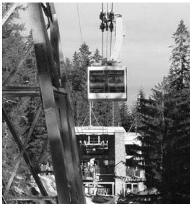
Il. 16. Tatry Polskie. Dolna stacja kolei linowej PKL w Kuźnicach. Kolej wyposażono w nowe wagoniki, po remoncie wykonanym przez szwajcarską firmę Garaventa w latach 2006–2007. Oprócz wymiany wagonów, podpór i lin – zamontowano nowoczesny napęd i układ sterowania kolei. Źródło: Archiwum autora
