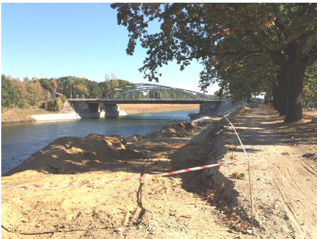
Ryc. 3. Przejście pod Mostami Jagiellońskimi w trakcie realizacji. Źródło: fot. autor
