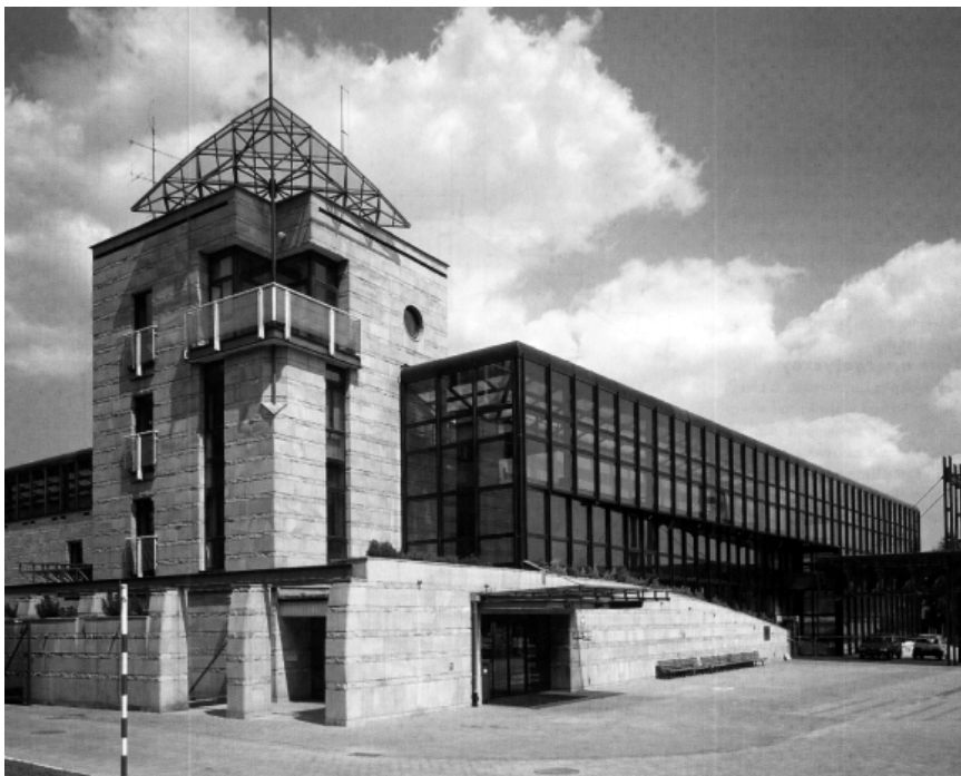
Ryc. 9. Terminal T-1 na lotnisku w Balicach (S. Deńko, D. Gruszka, J. Duliński i P. Wróbel, 1988). Źródło: archiwum pracowni APA.
