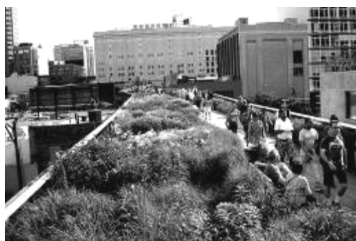
Ryc. 3. St. Zjednoczone. Nowy Jork. High-Line. Fragment parku linearnego zrealizowany na nieczynnym wiadukcie kolejowym w fazie sukcesji naturalnej. Źródło: fot. [25]
