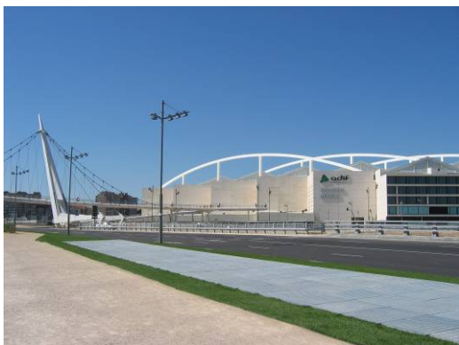
Il. 2. Estacion Intermodal Delicias i towarzysząca jej kładka piesza nad drogą szybkiego ruchu – widok od strony wschodniej. Źródło: fot. M. Gyurkovich
