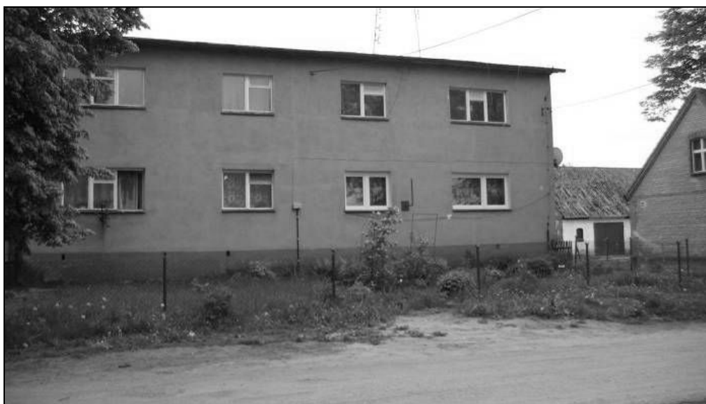
Fot. 12. Wieś Czarnocin - budynek mieszkalny pracowników nie istniejącego już PGR-u – stan z 2004r. Fot. autor.
