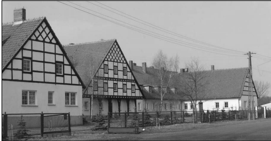
Fot. 7. Przedwojenny budynek „szkoły SS” adoptowany na ośrodek kolonijny we wsi Czarnocin – stan 2004r. Fot. autor.
