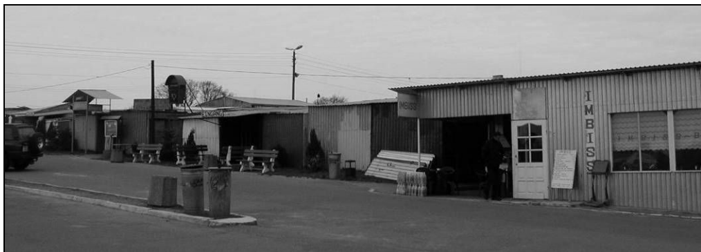
Fot. 5. Krajnik Dolny – fragment zabudowań bazarowych – stan 2004r. Fot. autor.
