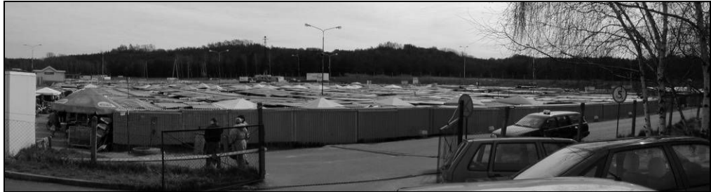
Fot.4. Osinów Dolny – kontenerowa zabudowa targowiska – stan 2004r. Fot. autor.
