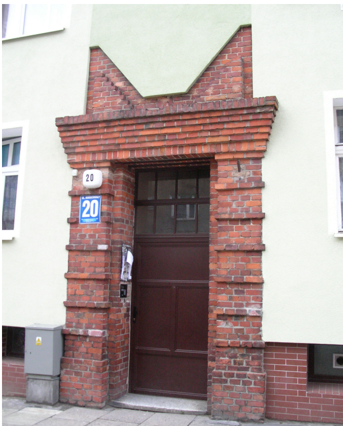
Ryc. 6. Wejście do budynku przy ulicy Boguchwały 20. Ekspresyjne przetworzenie formy portyku wejściowego.
