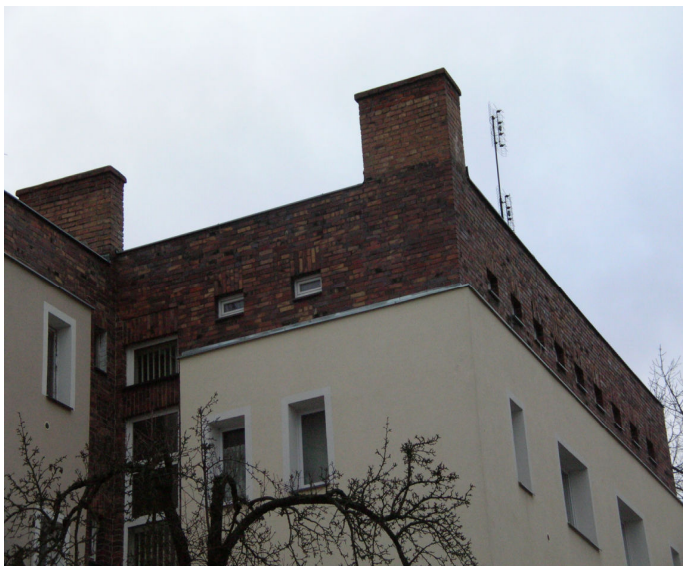
Ryc. 5. Zwieńczenie budynku przy ulicy S. Brzozowskiego 29. Płaski dach akcentowany poprzez poddasze.
