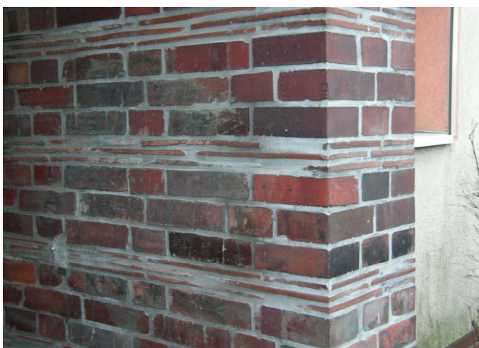
Ryc. 2. Wejście przy ul. A. Mickiewicza 133. Przykład oryginalnego wątku ceglano-ceramicznego, wykorzystującego płaskie płytki ceramiczne. Fig. 2. Street entrance at A Mickiewicz street 133. An example of the original thread brick, using flat tiles.
