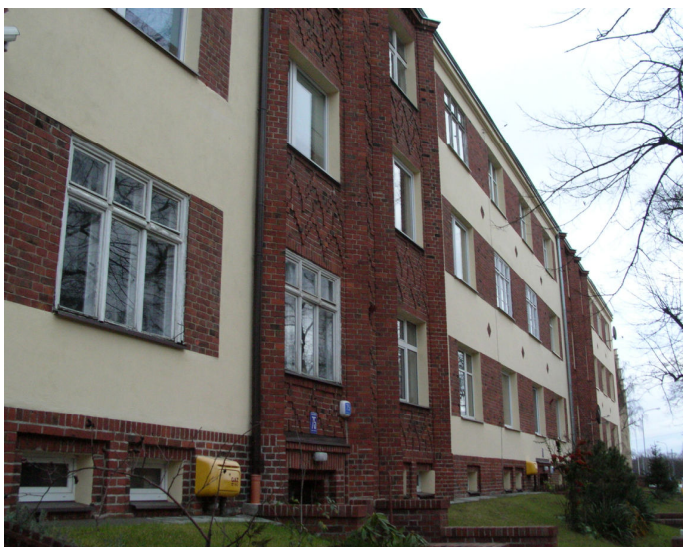
Ryc. 1. Elewacja budynku przy ul. A. Mickiewicza 75. Rzadki przykład bardzo znaczącego wykorzystania cegły w przestrzeniach między otworami okiennymi, oraz stosowania geometrycznych płaskorzeźb z cegły.
