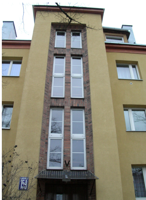
Ryc. 4. Akcentowanie klatki schodowej przy ul. A. Mickiewicza 159.
