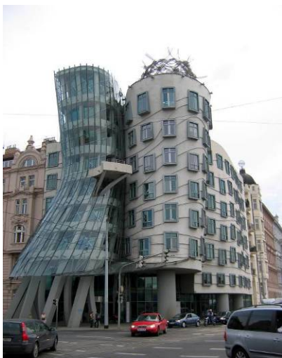
Il. 34. Czechy, Praga, Śródmieście, narożnik przy wybrzeżu Wełtawy naprzeciw Wzgórza Zamkowego i Katedralnego Hradczany, „Tańczący Dom Ginger i Fred” – budynek korporacyjny d. Nationale Nederlanden, obecnie ING. Arch. Frank Owen Gehry (właśc. Ephraim Goldberg). Obiekt jest wypadkową pomiędzy dość nieśmiałą podówczas dekonstrukcją autora – a wymogami konserwatorskimi w post komunistycznej Pradze, w rejonie najwyższej kontekstualnej ochrony. Źródło: fot. Justyna Koba
