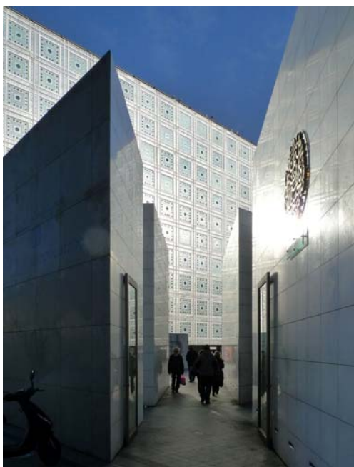
Ryc. 1. Paryż, Centrum Kultury Świata Arabskiego (Institut du Monde Arabe), projekt J. Nouvel (1981-1987). Źródło: foto autor.
