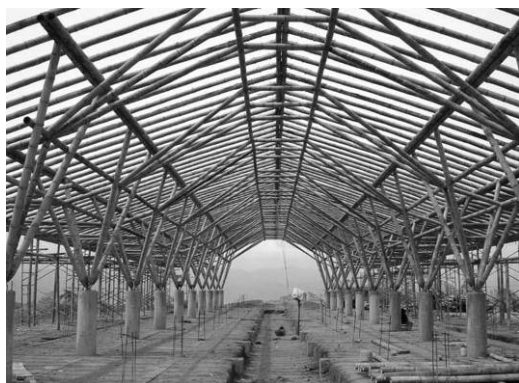
Il. 11. Simon Velez. Hala o konstrukcji przestrzennej płatiwio-słupowej Źródło: [7]
