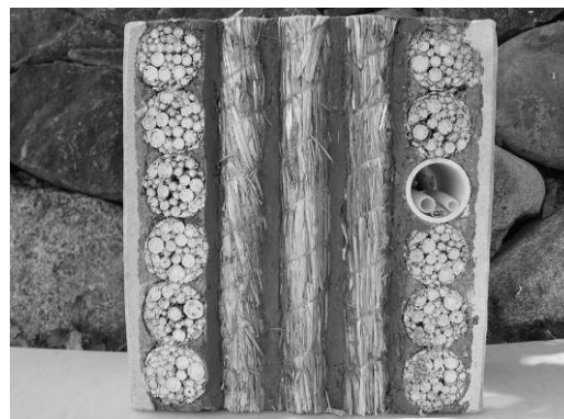
Il. 17. system ścienny strawJet z naprzemiennym ustawieniem mat. Źródło: [10]
