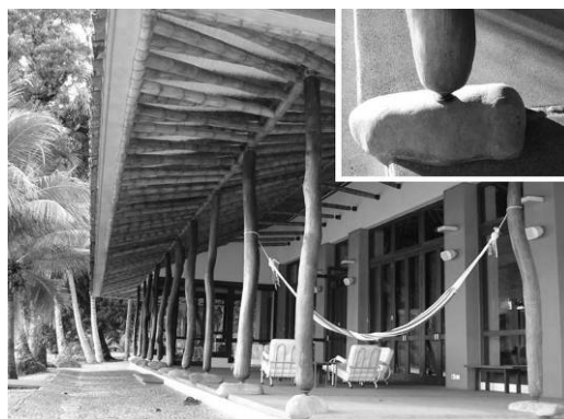
Il. 12. Simon Velez. Dom mieszkalny w Panamie. Słupy wykonane z drzewa namorzynowego połączone punktowo łącznikiem stalowym z kamieniem. Źródło: [7]
