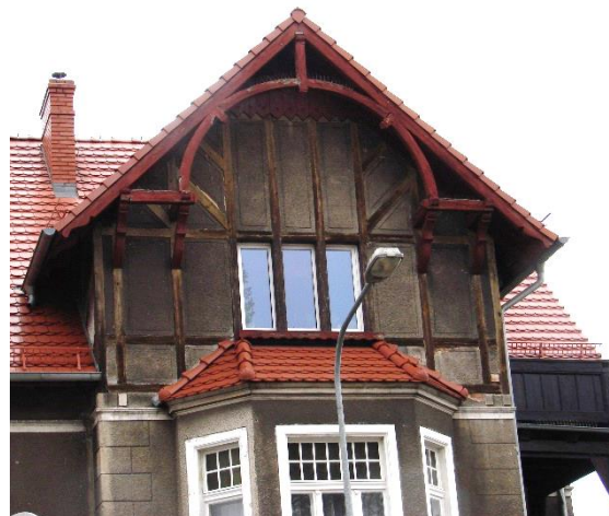
Fig. 9b. Zielona Góra. The southern elevation of the villa at 5 Stanisława Wyspiańskiego Street. Source: autor's photo
