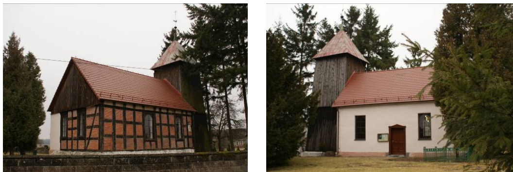
Rys. 8. Glewice - historyczny plan wsi, urządzenie parceli, rzut i przekrój kościoła, dwa widoki z północną elewacją szachulcową i południową otynkowaną w 1967 r.
