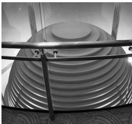
Ryc. 41. Stabilizator wewnątrz wieżowca Taipei 101. Źródło: skyscrapercity.com
