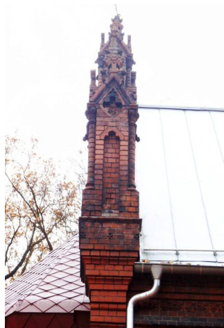
Ryc. 18. Ceramiczny pinakiel na poziomie gzymsu korony muru zewnętrznego. Źródło: fot. H. Rutyna XI.2010
