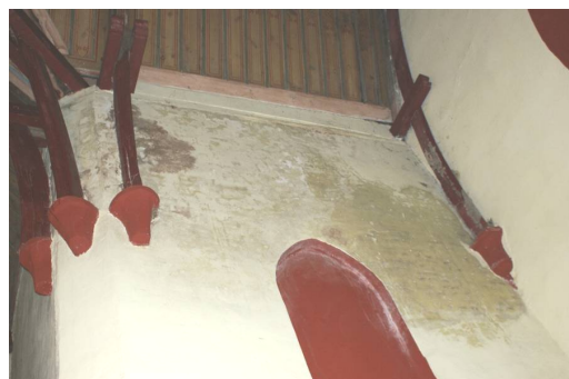
Ryc. 14 a, b. Brak szczelności pokrycia dachowego przez lata przyczynił się do powstania problemów ciepłno-wilgotnościowych ścian budowli. Źródło: fot. H. Rutyna XI.2010
