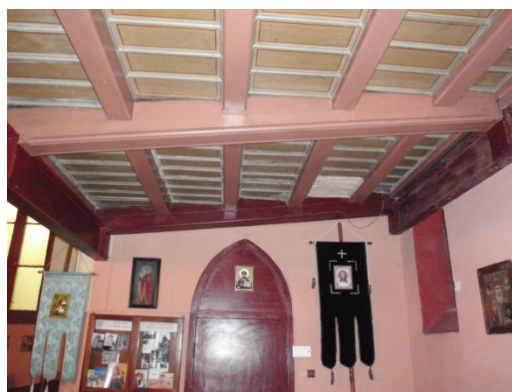
Ryc. 26. Skos pięciopozomowego układu empyry chórowej widoczny od spodu. Źródło: fot. H. Rutyna XI.2010
