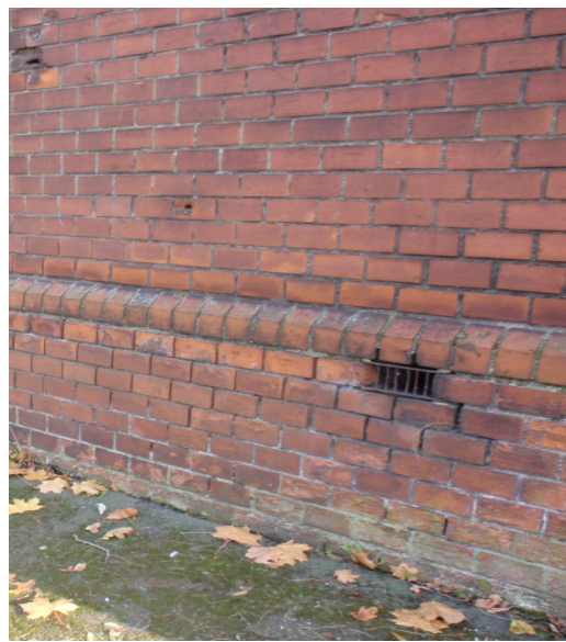
Ryc. 9. Miejscowe zapadnięcie się opaski betonowej i brak fug na elewacji ceglanej. Źródło: fot. H. Rutyna XI.2010
