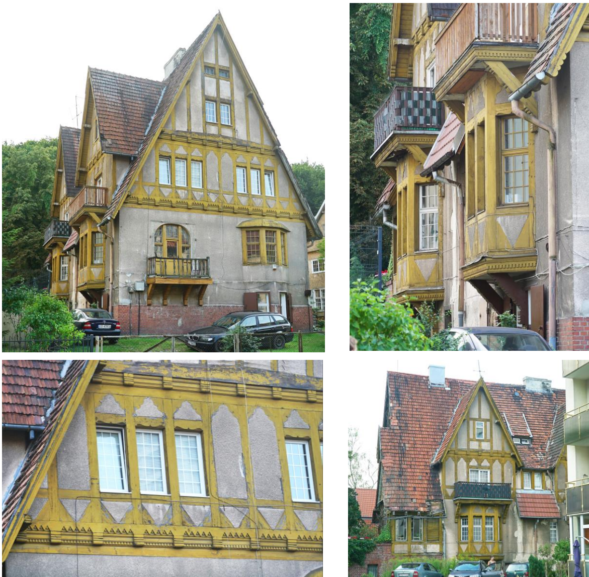
Fig. 39, 40, 41, 42. General view and details of the tenement house at 5 Pawłowskiego Street. Source: original photo Ryc. 39, 40, 41, 42. Ulica Batorego 8, kamienica czynszowa z przełomu XIX i XX wieku – widoki ogólne i detale konstrukcji drewnianej. Źródło: fot. autor 2020
