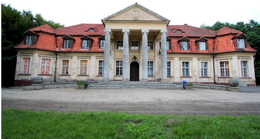
Ryc. 1. Pałac w Bieganowie, elewacja frontowa, 2013. Źródło: il. J. J. Białkiewicz
