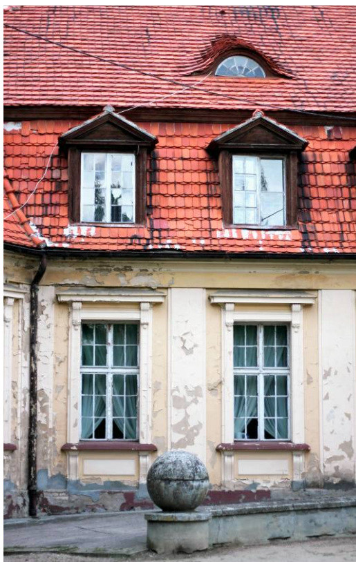
Ryc. 5. Pałac w Bieganowie, elewacja frontowa, 2013. Źródło: il. J. J. Białkiewicz
