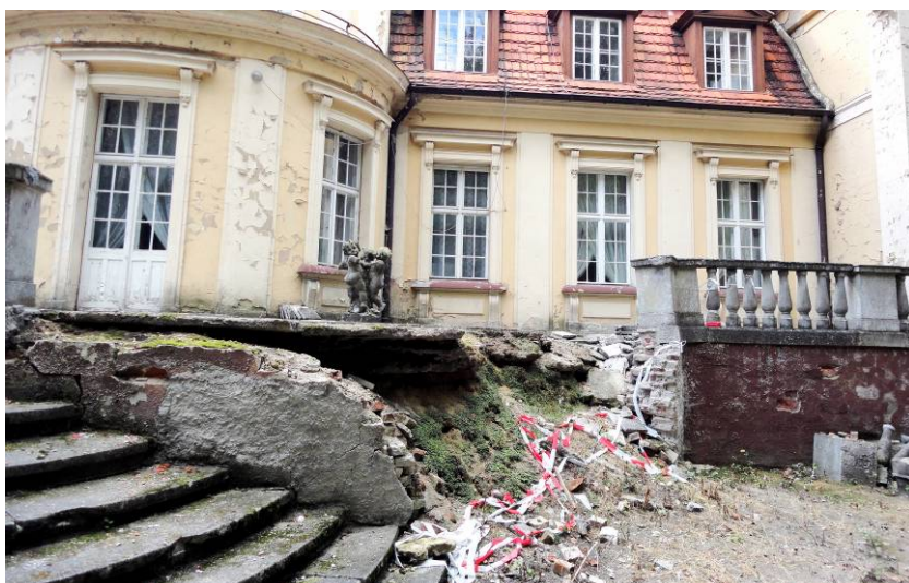
Ryc. 9. Pałac w Bieganowie, elewacja ogrodowa, zrujnowany taras, 2013. Źródło: il. J. J. Białkiewicz
