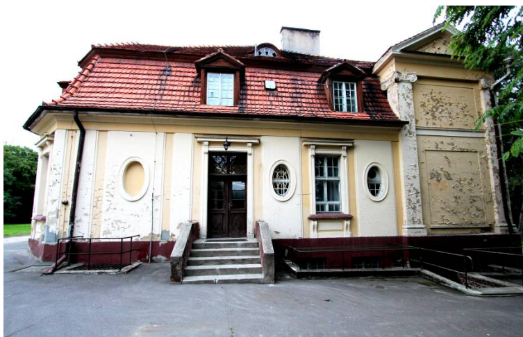
Ryc. 3. Pałac w Bieganowie, elewacja boczna, 2013. Źródło: il. J. J. Białkiewicz Fig. 3. Palace in Bieganowo, side façade, 2013. Source: photography of J. J. Bi- ałkiewicz
