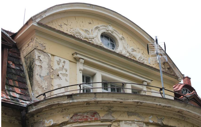
Ryc. 20. Pałac w Bieganowie, elewacja ogrodowa, odpadająca tynki, 2013. Źródło: il. J. J. Białkiewicz
