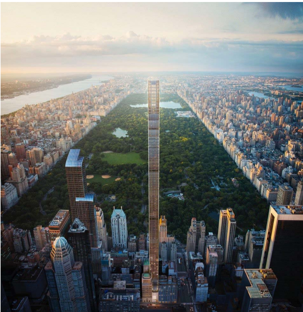
Fig. 8. Supertall and superslim skyscraper at 111 W 57th Street at a height of 438 meters designed by SHoP Architects. The planned completion of the construction will take place in 2018. Source: SHoP Architects. Ryc. 8. Superwysoki i supersmukły, wieżowiec przy 111 W 57th Street, autorstwa SHoP Architects, o wysokości 438 m. Ukończenie budowy zaplanowane na 2018 rok. Źródło: SHoP Architects.
