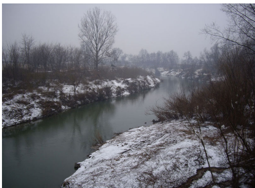
Ryc.10. Brzegi Raby w trakcie prowadzenia remontu. Źródło: fot. autora.
