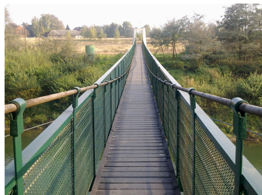
Ryc. 13. Wymienione elementy nośne oraz nowa konstrukcja balustrady. Źródło: fot. autora. Fig.13. New support elements and a new railing design. Source: photo by author
