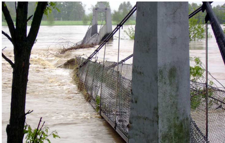
Ryc.4. Kładka w trakcie powodzi w 2009 roku. Źródło: fot. Parafia św. Joachima w Krzyżanowicach.
