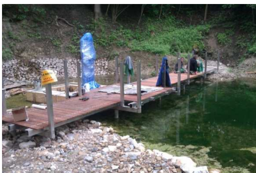
Ryc. 7. Źródło Dłubni w Sułkowicach podczas robót budowlanych przy zagospodarowaniu otoczenia wypływu jako przestrzeni rekreacyjnej. Źródło: fot. M. Zieliński
