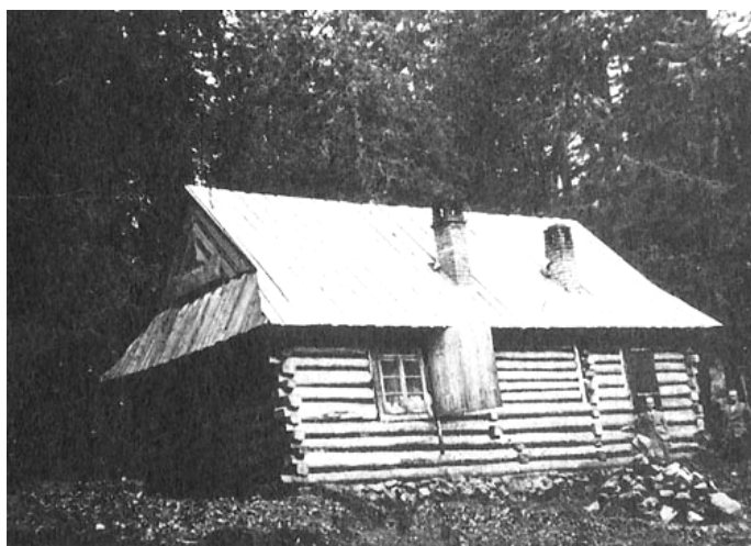
Il. 5. Tatry Polskie. Hala Pyszna. Schronisko PTT przed przebudową ok. 1914 r. Źródło: M. Kulig, Architektura schronisk tatrzańskich, Wydawnictwo Neriton, Warszawa 2003, s. 15
