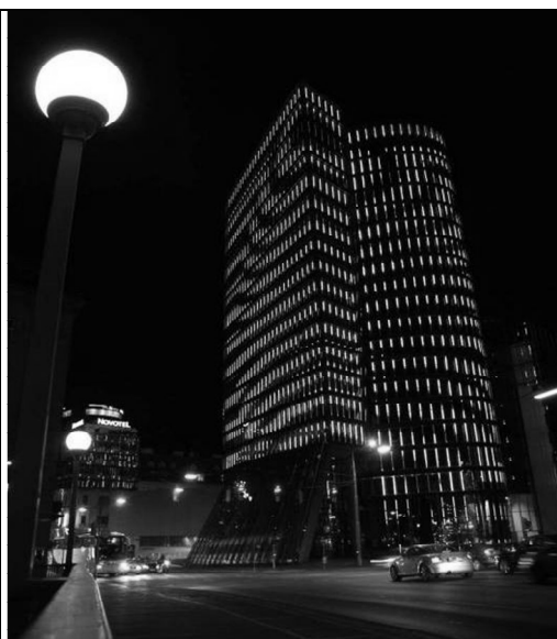
Fot. 3. Fasada medialna budynku Uniqa Tower Wiedeń, Austria, 2008 (fot. P. Kowalski)
