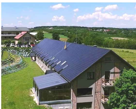
Fig. 15. Hotel building. Source: Szary 2023 Ryc. 15. Budynek hotelu. Źródło: Szary 2023
