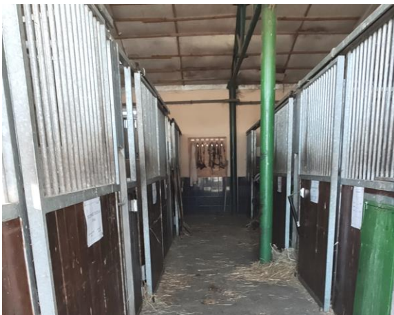
Fig. 12. Stable – internal view. Source: photo author. Ryc. 12. Stajnia – widok z wnętrza. Źródło: fot. autor
