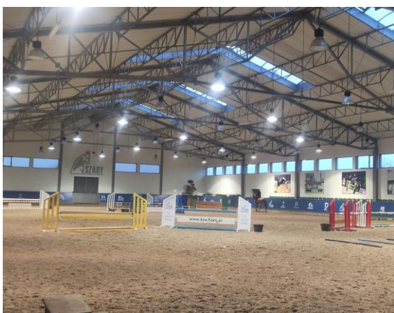
Fig. 14. Riding hall – internal view. Source: photo author Ryc. 14. Hala jeździecka – widok z wnętrza. Źródło: fot. autor
