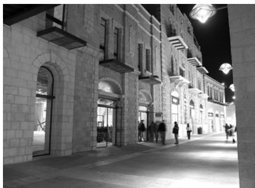
Il. 12. Pasaż Jaffy. Nawierzchnia ulicy jest elementem plastycznie łączącym i scalającym nową i starą tkankę miejską. Źródło: fot. W. Kosiński
