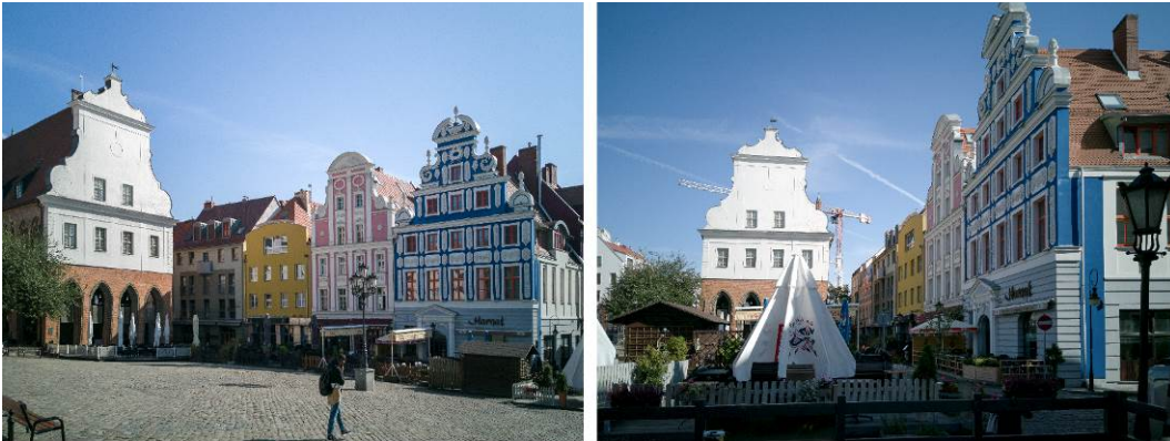
Fig. 15. The restored Rynek Sienny – as seen in 2019. Source: original photograph Ryc. 15. Odbudowany Rynek Sienny – stan na 2019 r. Źródło: zdjęcia autora
