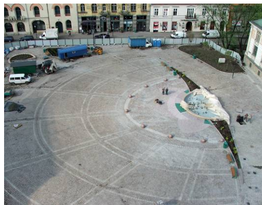
Ryc. 44. Rewaloryzacja Placu Szczepańskiego w trakcie prac budowlanych. O ile znakomita była sama idea usunięcia parkingu z Placu i przywrócenie mu roli oraz wyglądu salonu kulturowego, o tyle jej realizacja ma fundamentalne wady, co najmniej trzy. Po pierwsze zaniechano zbudowania pod placem parkingu, co najmniej dwupoziomowego. Po drugie pominięto znakomitą okazję wytworzenia osiowego wejścia do Pałacu Sztuki. Po trzecie, wreszcie, last but not least, kiczowata / drobno-mieszcząńska / galanteryjna i uboga jakościowo choć „przegadana” estetyka, nijak się ma do wspaniałego miejsca w gotyckim i renesansowym mieście – stołecznym i królewskim, w XXI wieku – epoce minimalizmu i w ogóle nowoczesności. Fot. Jacek Sanecki
