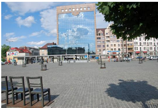
Ryc. 74. Budynek wysoki – Bank B.P.H. (Janusz Gawor) przy Pl. Bohaterów Getta na Podgórzu (por. ilustr. 80). Przebudowany w stylu postmodernistycznym z wcześniejszego biurowca socjodemokratycznego, autorstwa tego samego architekta. Stanowi wyróżniający akcent w drobnoskalowym otoczeniu ubogiej dzielnicy przemysłowej. Fot. Mariola Heinrich
