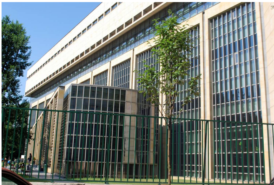
Ryc. 63. Nowy Gmach Biblioteki Jagiellońskiej, ul. Oleandry. Prawdopodobnie najlepsze dzieło kontrowersyjnego architekta Romualda Loeglera. Stanowi znakomitą, ale nie naśladowczą kontynuację sąsiadującego, głównego budynku „Jagiellonki”, widocznego na fot. 50. Fot. Mariola Heinrich
