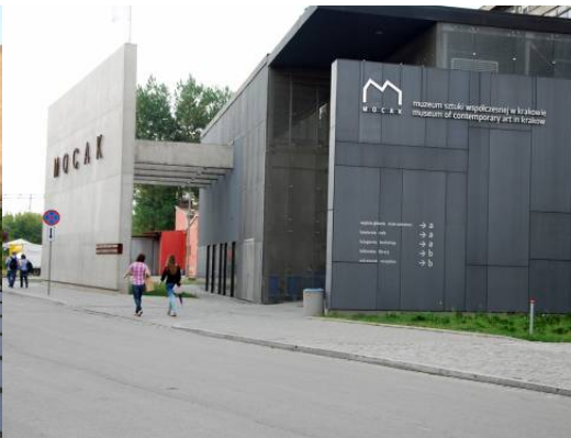
Ryc. 101. MOCAK; pol. Muzeum Sztuki Współczesnej w Krakowie. Zespół wejściowy – najbardziej ekspresyjny w obiekcie / zespole, zwracający uwagę w zaniedbanej dzielnicy przemysłowej i zachęcający do odwiedzin. Zasadniczą kubaturę stanowi twórczo zaadaptowana dawna fabryka naczyń emaliowanych kierowana przez niemieckiego przedsiębiorcę Schindlera, który zasłynął ratowaniem żydów przez holocaustem, dzięki zatrudnieniu w tej fabryce. Fot. Mariola Heinrich
