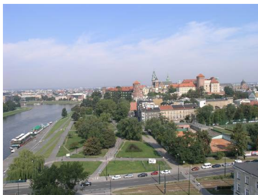
Ryc. 1. Wawel od południa – z lewej strony Wisła, całkiem z prawej daleko w głębi kościół św. św. Piotra i Pawła. Najwyższa, dominująca na zamku baszta Senatorska (zwana także Lubranka) została w 2003 roku przywrócona do pierwotnego wyglądu, poprzez położenie pochylego dachu na austriackim płaskim stropodachu z eklektycznym krenelażem z 1858 r. Nastąpiło więc upodobnienie do drugiej z głównych baszt – Sandomierskiej (obydwie stanowią tzw. baszty ogniowe, pochodzą z XV wieku). Radykalnie zmieniło to – po 145 latach – sylwetkę Wawelu. Fot. Wojciech Kosiński
