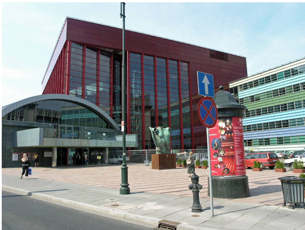
Ryc. 68. Opera – przy ul. Lubicz (z lewej), narożnik u zbiegu ul. Iwony Borowickiej (z prawej, niewidoczna). Na forum rzeźba Igora Mitoraja. Autor wykonał dwa ważne zabiegi kontekstualne. Po pierwsze zaadaptował formę dawnej Ujeżdżalni / Operetki położonej wzdłuż linii regulacyjnej ul. Lubicz. Po drugie – w budynku pomocniczym przy ul. Borowickiej, nawiązał gabarytami do sąsiadującego gmachu PKP z okresu socrealizmu. Zdumiewa zupełne zignorowanie kwestii parkowania (mini parking podziemny z fatalnym dojazdem ma praktycznie zerową przydatność. Główny gmach – czerwony prostopadłościan z przeszkleniami jest kontrowersyjny, ale oprócz kontrowersji są też uprawnione argumenty pozytywne. Fot. Wojciech Kosiński
