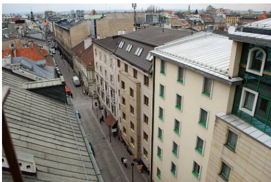
Ryc. 26. Ulica św. Tomasza, przykład regularnej geometrii lokacyjnej i regulacji urbanistyczno architektonicznej w odniesieniu do zabudowy pierzejowej w latach 20-30. XX w. i obecnie. Po prawej stronie nowy Hotel Campanile. Ulica prowadzi do Zaułka św. Tomasza, jak na fot. 20 (widoczna w górnym lewym narożniku wieżyczka kościoła Panien Prezentek). Widok z tarasu Akademii Muzycznej. Fot. Mariola Heinrich
