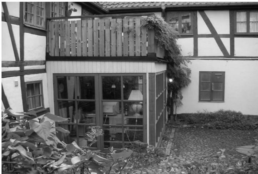
Fot. 36. Wewnętrzny dziedziniec domu. Ystad. Forma „wypychająca” wnętrza domu w przestrzeń dziedzińca wykonana ze szkła, przez co uzyskano efekt wizualnego połączenia obu przestrzeni. Wyk.: Autorka
