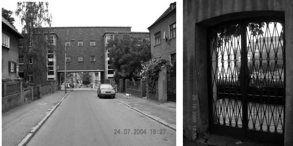
Fot. 34. Budynek z łącznikiem nad ulicą. Stargard Szczeciński; Fot. 35. Brama w długim monotonnym murze, otwierająca rozległy widok. Kraków. Wyk.: Autorka
