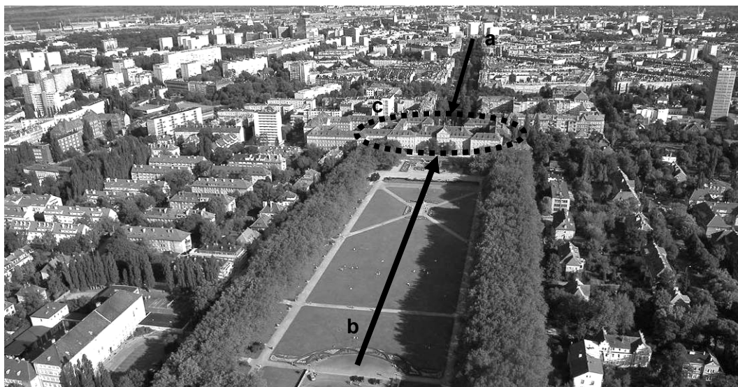
Il. 1. Zdjęcie lotnicze fragmentu Szczecina prezentujące oś alei Jana Pawła II (a) oraz założenie Jasnych Błoni (b), na zamknięciu których znajduje się budynek Urzędu Miejskiego (c). Dzięki lokalizacji obiekt zyskał na znaczeniu, a jego walory architektoniczne zostały podkreślone i wyeksponowane. Źródło: fot. C. Skórka Fig. 1. Aerial photo of Szczecin showing: Jan Paweł II alee (a) and Jasne Błonie prospect (b) which are closed at the view ends with the City Hall (c).
