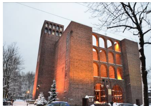
Ryc. 3. Kościół Św. Józefa. Elewacja płn.-wsch. Źródło: fot. autorka.
