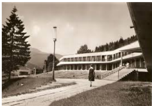
Ryc. 30. Ustroń-Jaszowiec. Dom Nauczyciela. Zbliżenie od strony wejścia.
