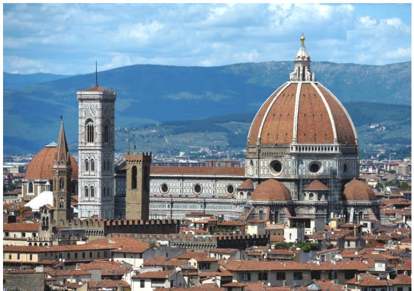
Fig. 14. Santa Maria del Fiore in Florence and the dome designed and constructed by Filippo Brunelleschi (1420-1436). Source: Kopała Ryc. 14. Bazylika Santa Maria del Fiore we Florencji i kopuła zaprojektowana i skonstruowana przez Filippo Brunelleschi (1420-1436). Źródło: Kopała
